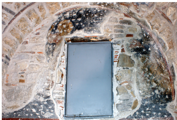
Εικ. 2. Όραμα προφήτη Ιεζεκιήλ- δυτικός τοίχος
