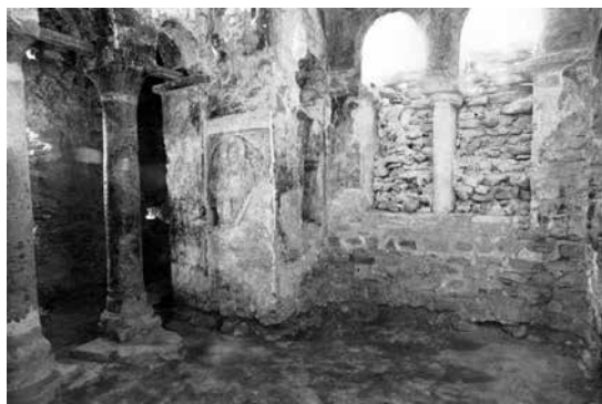
Сл. 3. Црква Свети Георги, северна бифора, поглед кон северо-запад
