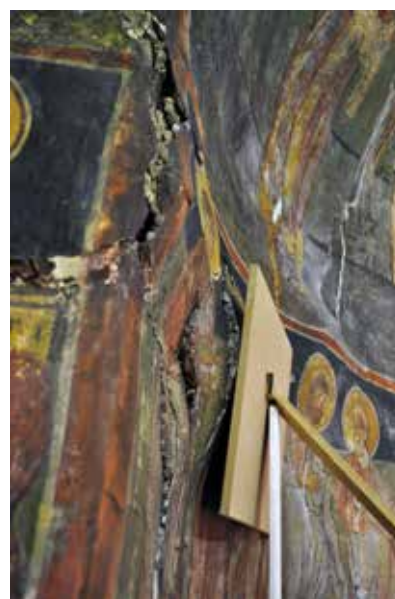
Сл. 10 Једна од потпора приликом имобилизације зона ињектирања.
