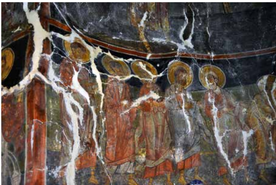
Сл. 11 Пломбиран сегменат након ињектирања тврдом пеном. Fig. 11 Filling up area after injection hard foam.
