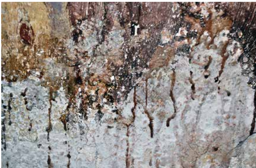
Сл. 2 Цурење фирнајса – затечено стање. Fig. 2 Tearing of firmiss – swell condi- tion.
