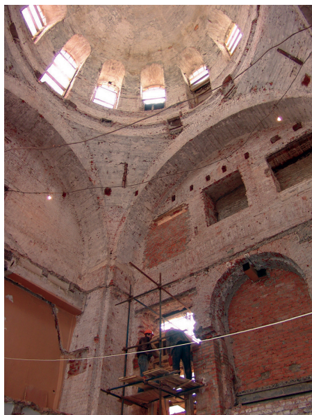
16. Московски Епархијски Дом. Купола цркве Св. кнеза Владимира током реставрације. Архива Православног Свето-Тихоновског универзитета.
