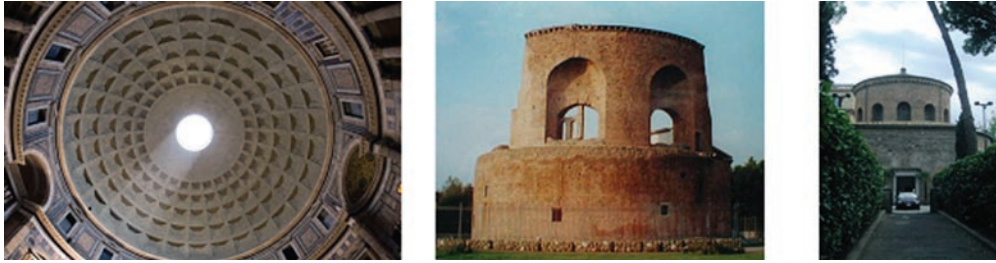
Fig. 1 The Roman domes rested on a circular drum: Pantheon, Torre Pignatarra, chiesa di Santa Constanza
